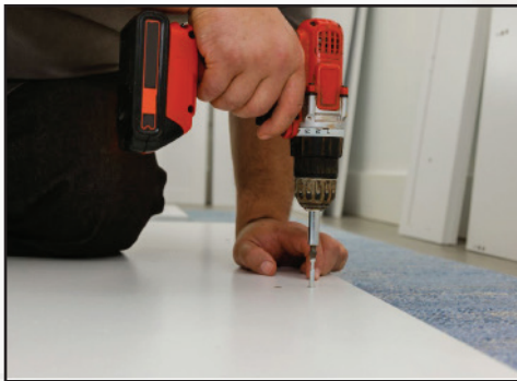
Rakentajalle ja remontoijalle
