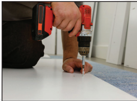
Rakentajalle ja remontoijalle
