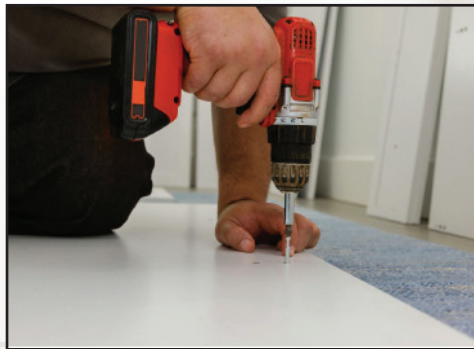
Rakentajalle ja remontoijalle
